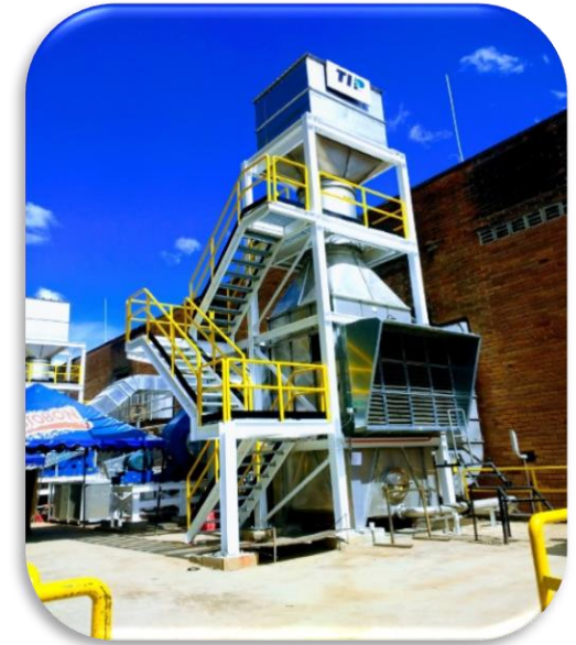
MONTAJE DE ESTRUCTURAS (PAPELSA)
